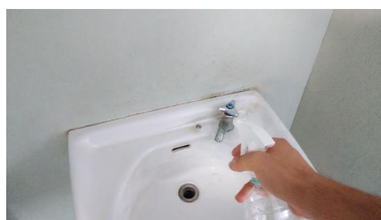
体育館トイレ内 水道
